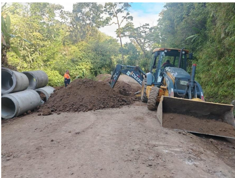
Foto: Colocación de alcantarilla, camino la 26, distrito de Pejivalle.
