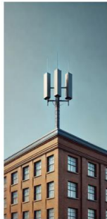
Edificios y/o sus Azoteas
