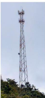
Torres de telecomunicaciones
